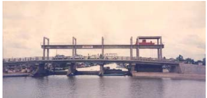
Công trình ngăn mặn giữ ngọt Phó Sinh (Bạc Liêu) năm 1998, 3 khoang x 7.5m, cao 6.0m. Cầu giao thông H13 –X60.
