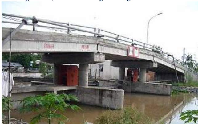
Công trình ngăn mặn giữ ngọt 14500C (Hậu Giang) năm 2007, 1 khoang x 7,3m, cao 4,8m. Cầu giao thông H8
