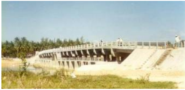
Công trình cống Hiền Lương (Quảng Ngãi) 16 khoang x 4.0m, cao 4.0m. Cầu giao thông H13 –X60
