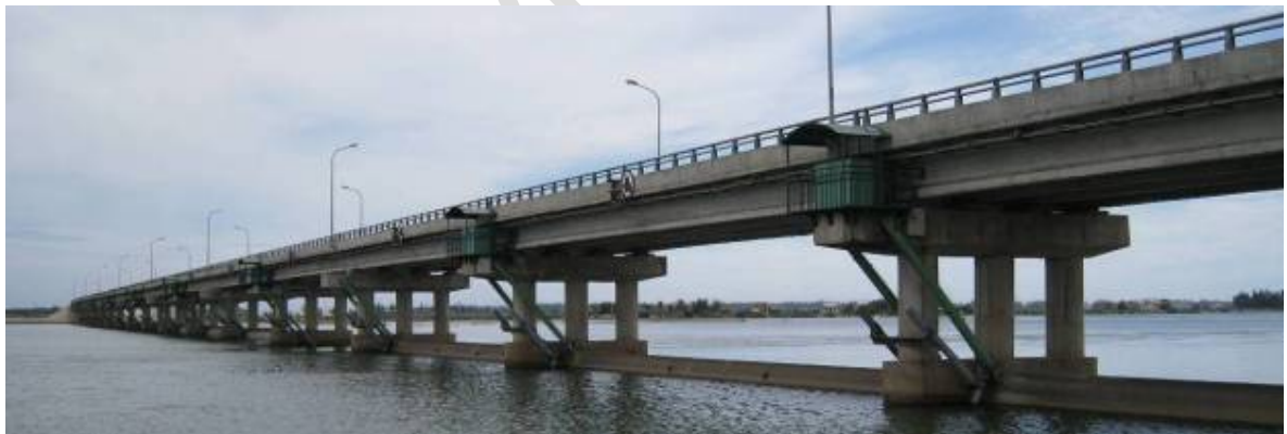
Công trình Thảo Long hoàn thành
