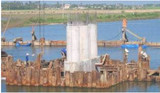
Thi công trụ trong khung vây
