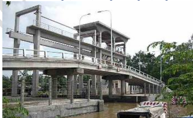
Công trình ngăn mặn giữ ngọt 7000c (Hậu Giang) năm 2007, 1 khoang x 10m, cao 4.8m. Cầu giao thông H8
