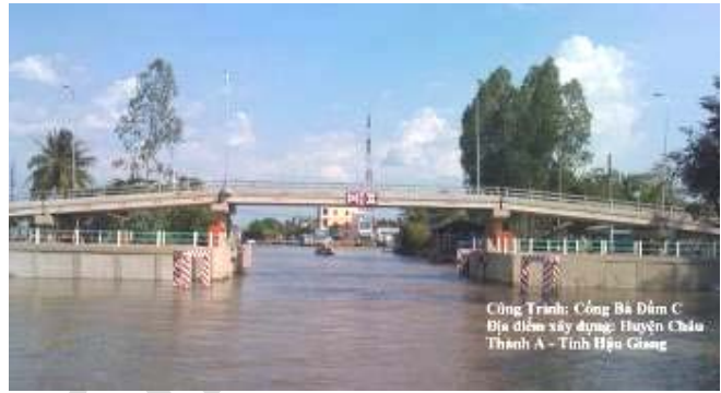
Công trình cống Bà Đầm C (Tỉnh Hậu Giang) Một khoang 5,2x16m, Cầu giao thông H8, rộng 4m
