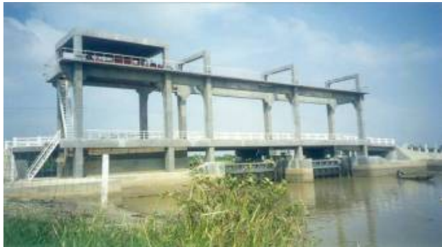
Công trình ngăn mặn giữ ngọt Sông Cui (Long An) năm 2001, 2 khoang x 7.5m, cao 6.0m. Cầu giao thông H13 –X60
